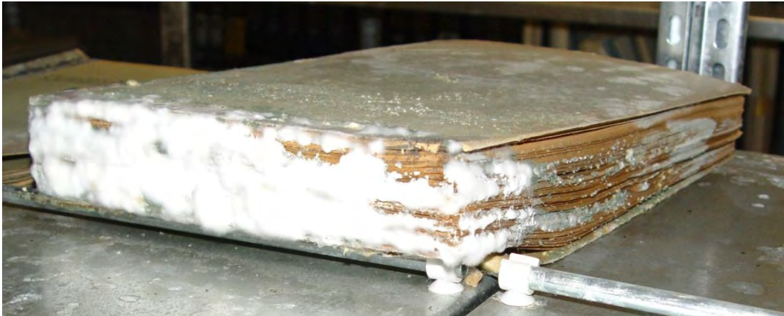
Abb.2: Unbemerkter Wasserschaden in einem Kellerraum, dadurch akute Schimmelschaden mit „Rasenbildung“. Foto: LVR-AFZ.
