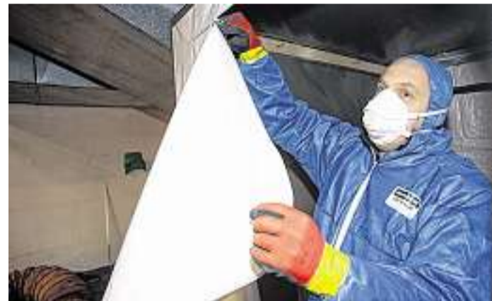
Timo Schön im Schutzanzug und mit Schutzmaske: Er gehört zu einem Team, das Mineralfasern entfernt, die schädlich sind.
